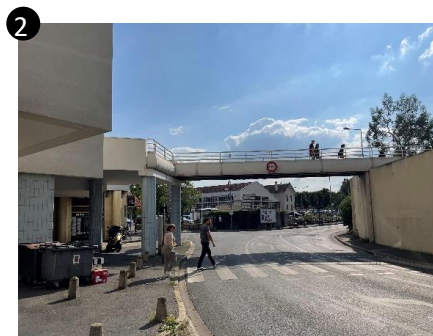
Passerelle surplombant la rue de la Marne
